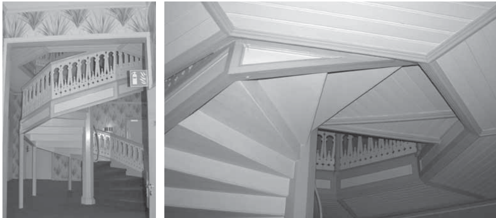
Entréhallens fristående trappa.
