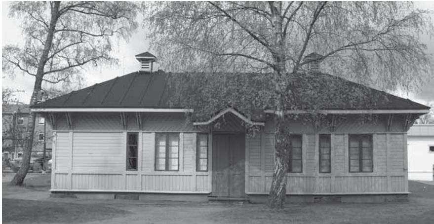
Uthuset, befintligt utseende.
