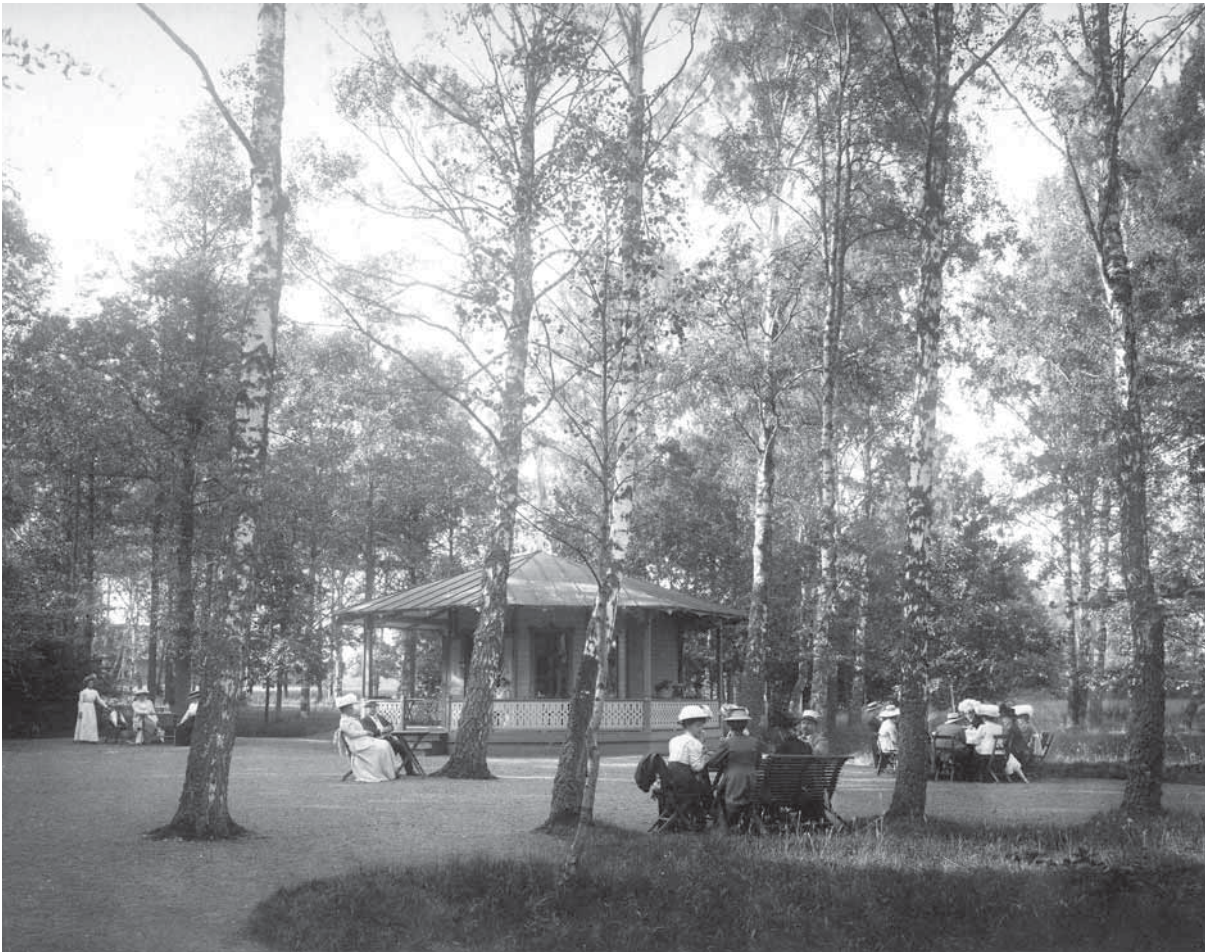
Schweizeriet med gäster. Björkarna fanns på plats när parken anlades och byggnaden uppfördes.
