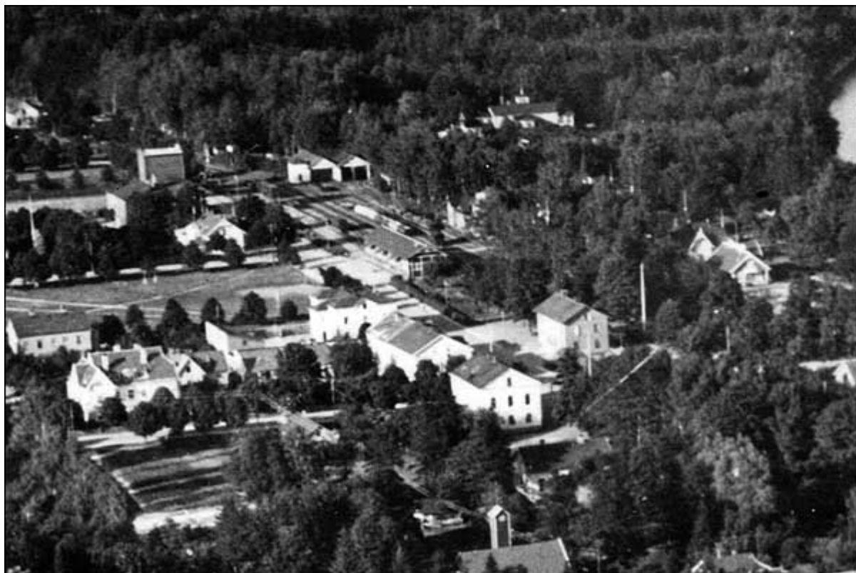
Stationsområdet i Hjo som det såg ut i slutet på 1940-talet. Stationshuset till höger om mitten. Snett upp till vänster om detta syns godsmagasinet samt lokstallet och verkstadsbyggnaden.
